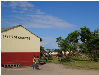
Blick auf einen Teil des Schulgeländes – die Gebäude blieben dank stabiler Bauweise nahezu unversehrt, die Bäume haben unter IDAI gelitten
