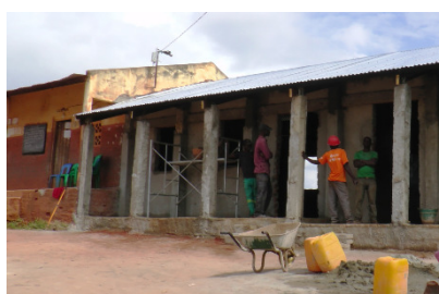
Das gleiche Schulgebäude während der Renovierung im Juni
