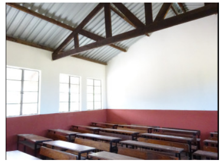
Alle Klassenräume und Schulmöbel befinden sich in einwandfreiem Zustand
