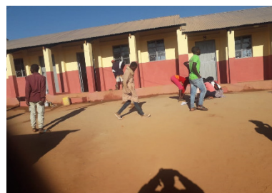
und nach der Fertigstellung Ende Juli 2019
