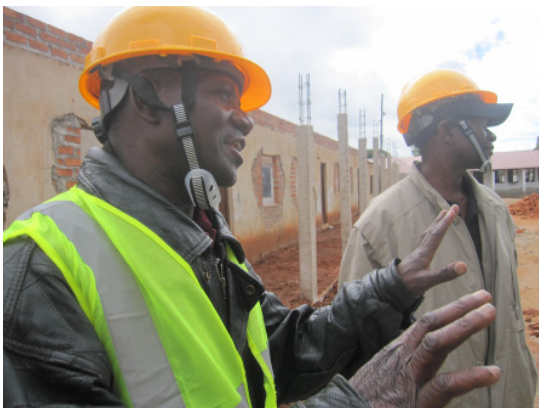
Filipe und Samuel vor dem entkernten alten Schulgebäude mit 6 Klassenräumen (Juli 2016)
