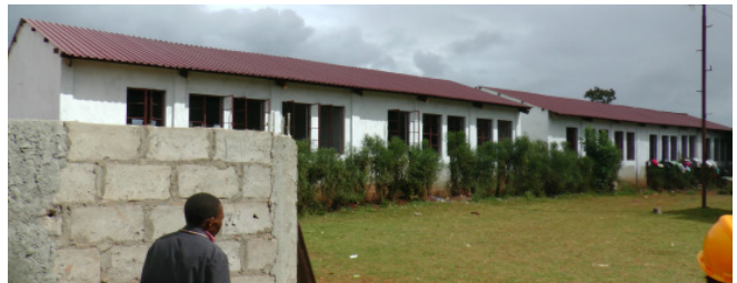
Rückseite der neuen Klassenräume (Juli 2016)
