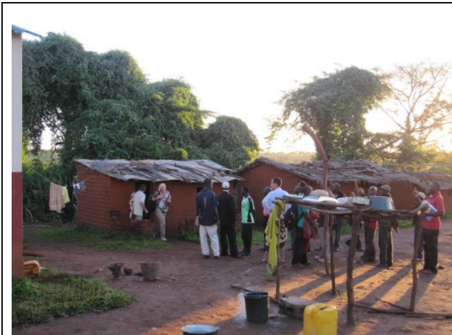
Die neuen, in Eigenleistung errichteten Lehrerhäuser
