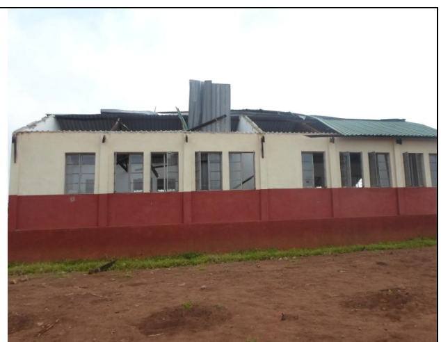
Das Schulgebäude von der Rückseite
