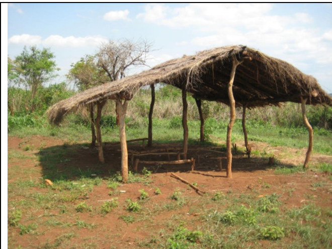
Schulgebäude in Cruzamento Rica im Oktober 2009
