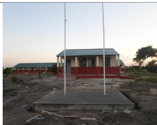
Fahnenmasten und Verwaltungsgebäude im Dez. 13
