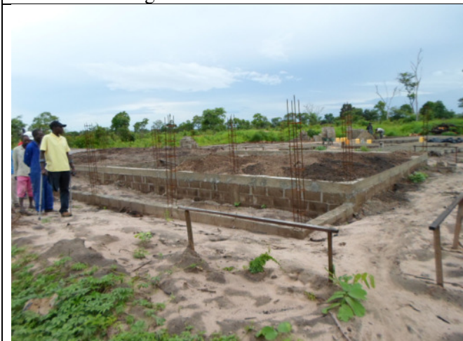
Das Fundament zu den 3 Klassenräumen (Jan 2013)
