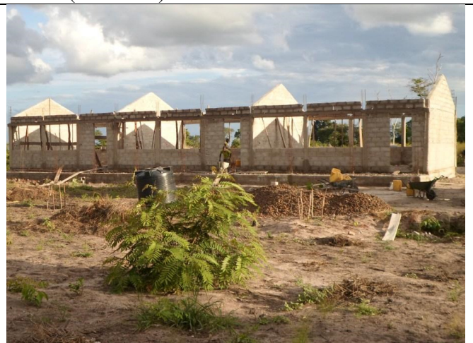
Der Baufortschritt im März 2013
